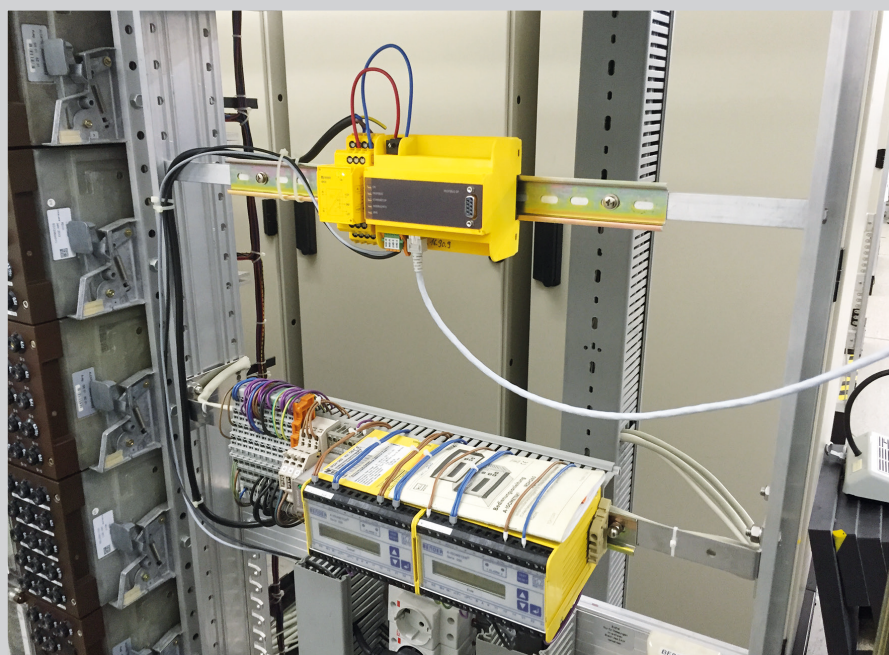
Bild 1: Datenlogger an RS485 Schnittstelle eines Bender IRDH265 in Plattling
