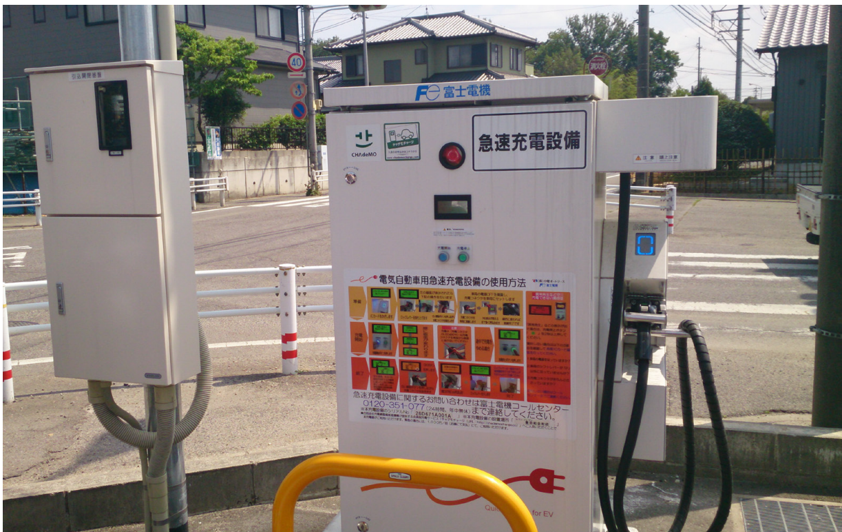
Abbildung 1: Öffentliche Schnellladestation auf einem "7eleven" Supermarktparkplatz
