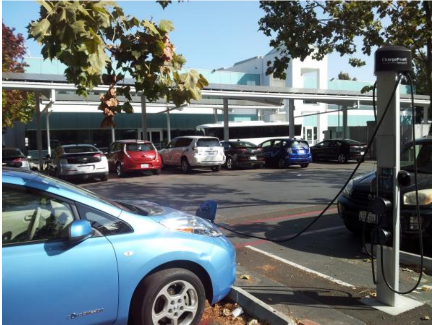
Abbildung 3: Google Mitarbeiterparkplatz mit Ladesäule
