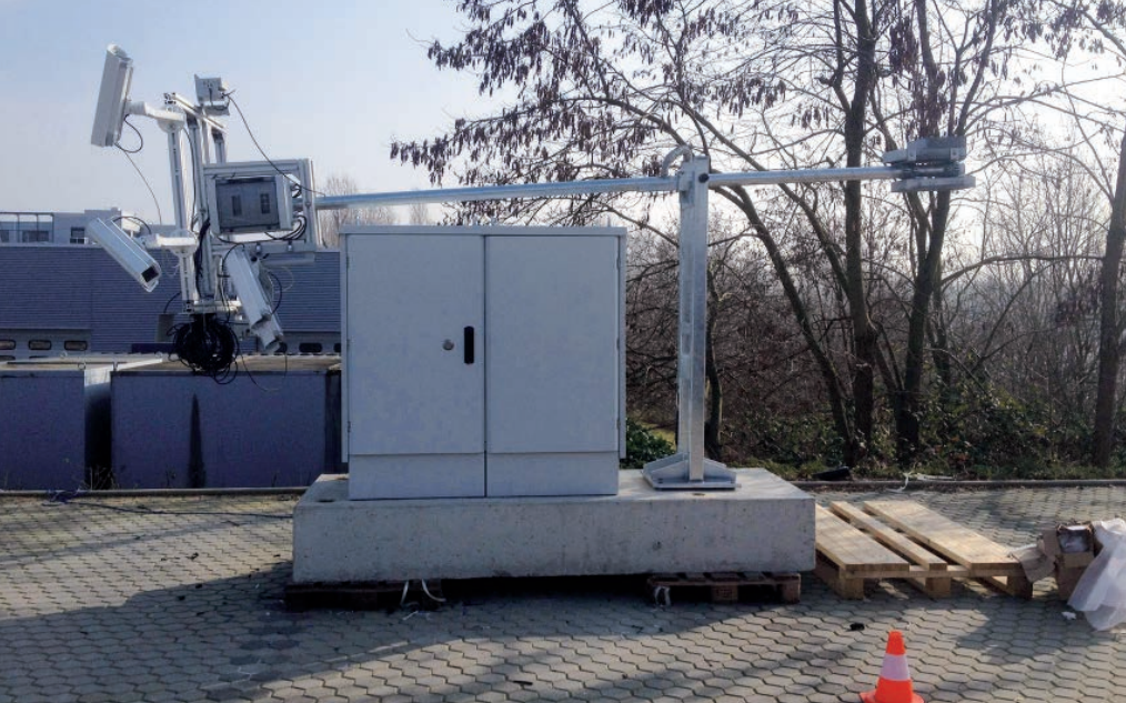
BILD 4: Semi-stationäre Multi-Sensor-Einheit des Forschungsbahnübergangs
