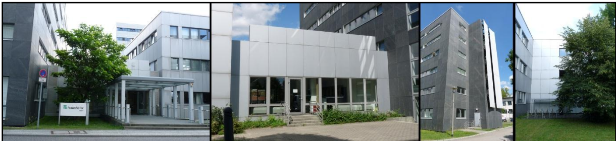
Abbildung 10: Gebäude B4 mit verschiedenen Fassadenhöhen und unterschiedlichen horizontalen Fassadenlängen (die drei Bilder links) und mit dichter Vegetation (rechts).
