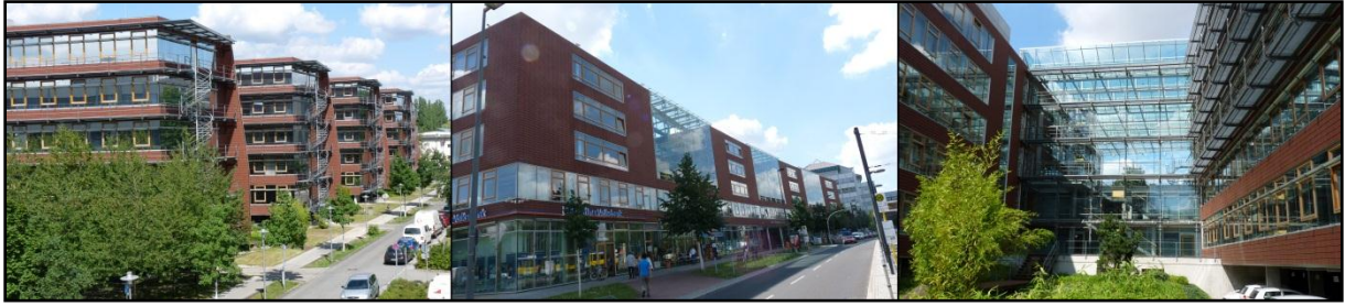
Abbildung 9: Gebäude B3 mit Balkonen und Rettungstrepfen an den Fassaden (links), gekrümmter vorderer Fassade (mitte) und vollständig verglasten Fassaden zwischen den vier Gebäudeteilen.
