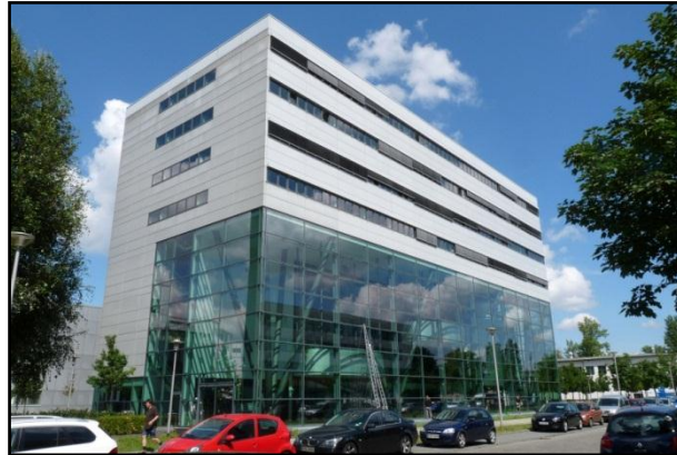
Abbildung 7: Gebäude B1 mit der teilweise verglasten Fassade.
