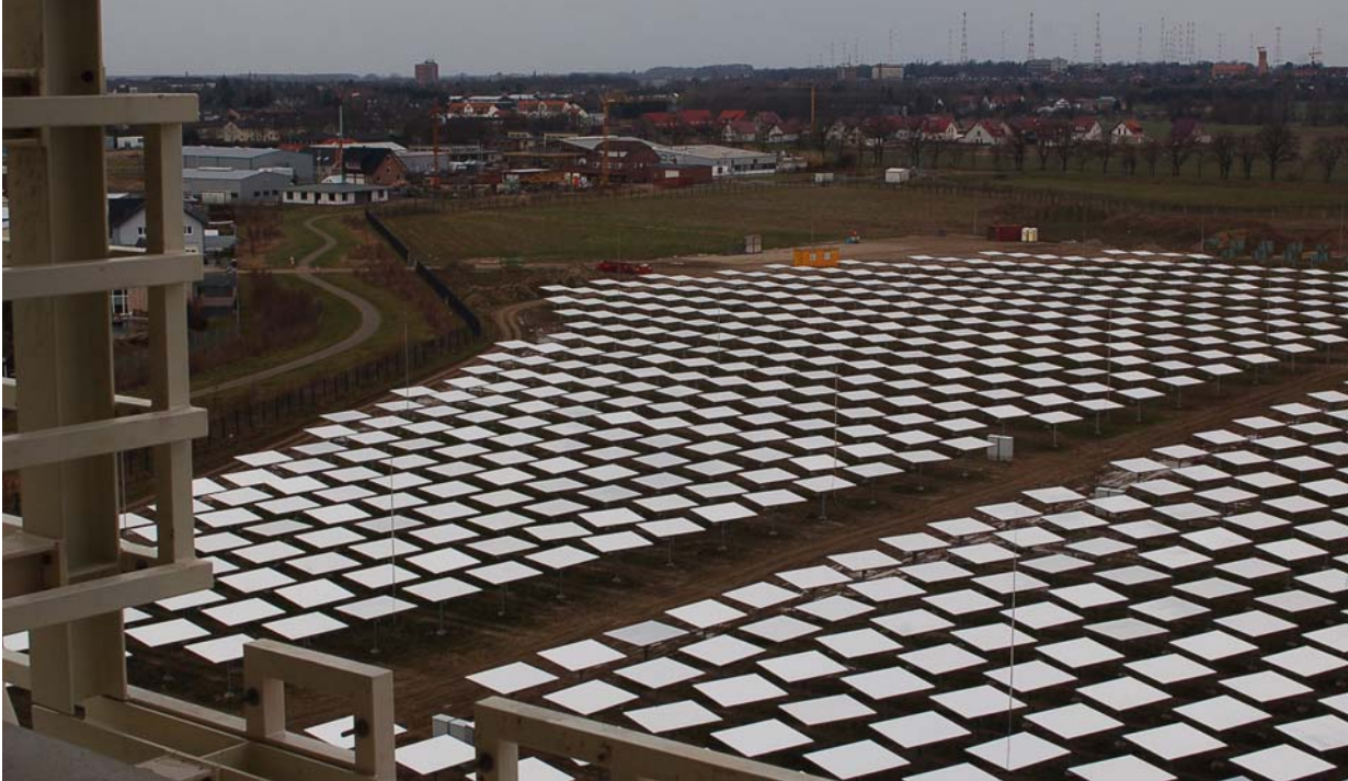
Abbildung 3: Blick aus der Öffnung der Forschungsplattform auf das westliche Heliostatfeld; am Bildrand ist der Tragerahmen des Strahlungsschutzes zu erkennen
