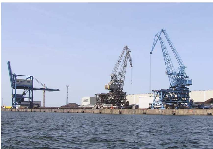
Abbildung 4-6: Krananlagen auf Pier 3 (westliche Kaibereich – Schüttguthafen)
