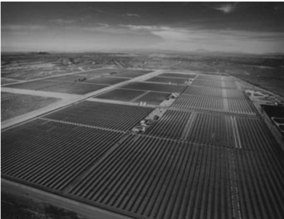
Abb. 1-1: SEGS-Kraftwerke III-VII bei Kramer Junction, Kalifornien
