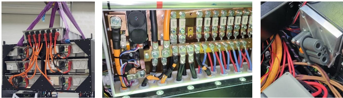
Abbildung 26: Einbau des Batterieracks (links), Energieverteilung und Absicherung 48 V (mittig), Ladestecker im Driveboard (rechts)
