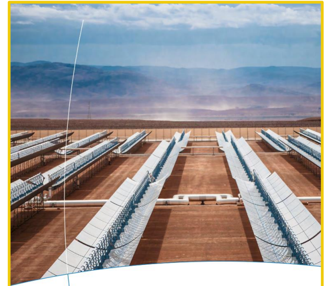
Solarthermische Kraftwerke Wärme, Strom und Brennstoffe aus konzentrierter Sonnenenergie
