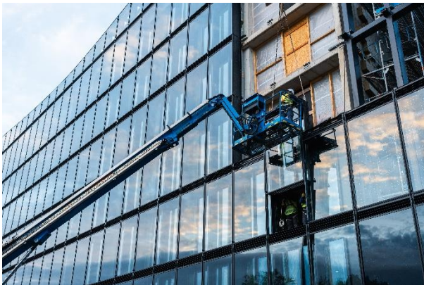
Abbildung 43: Montage einer vorgehängten Glasfassade, Quelle: HASKAMP GmbH & Co. KG
