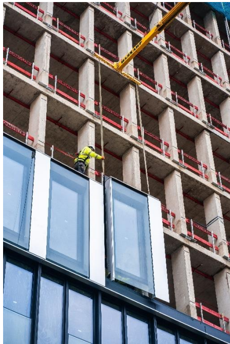
Abbildung 44: Montage einer integralen Fassadenelements, Quelle: HASKAMP GmbH & Co. KG
