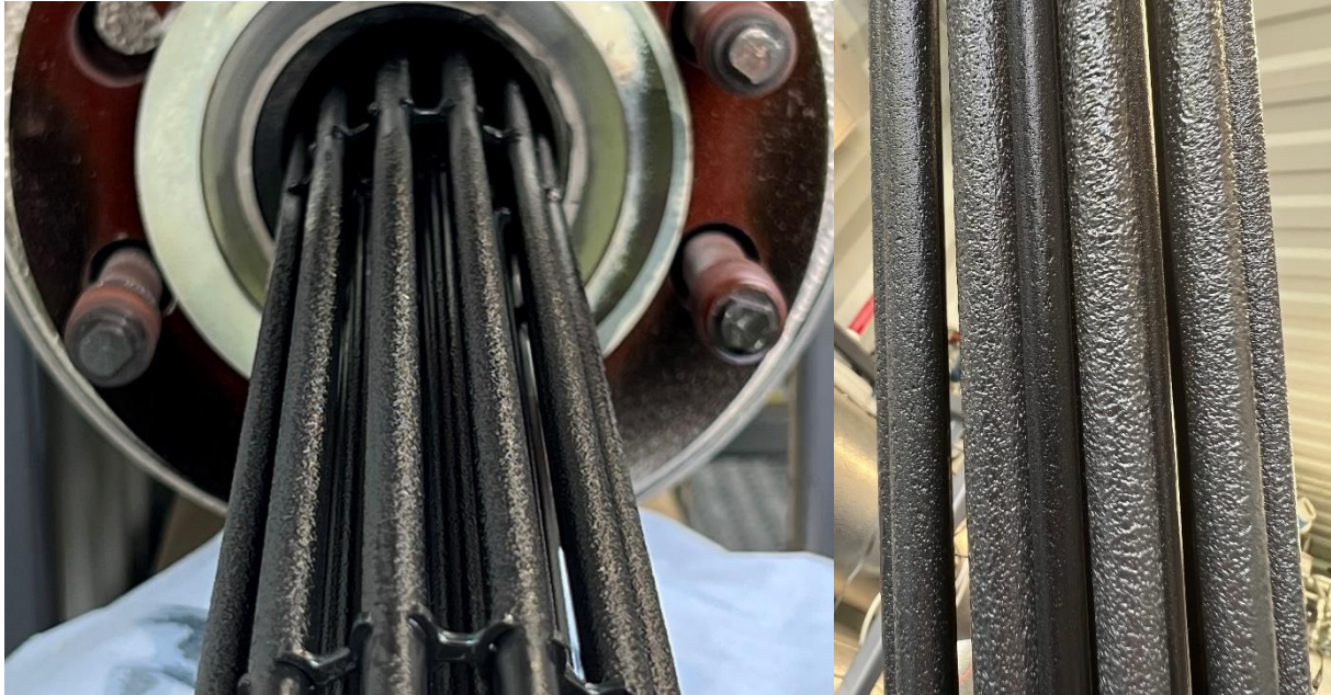
Abbildung 46: links: herausgezogene Heizung nach etwa 5000 h Betrieb bei Temperaturen \geq 450 °C, rechts: Draufsicht auf die Heizstäbe mit den schwarzen weichen Ablagerungen auf den Heizstäben
