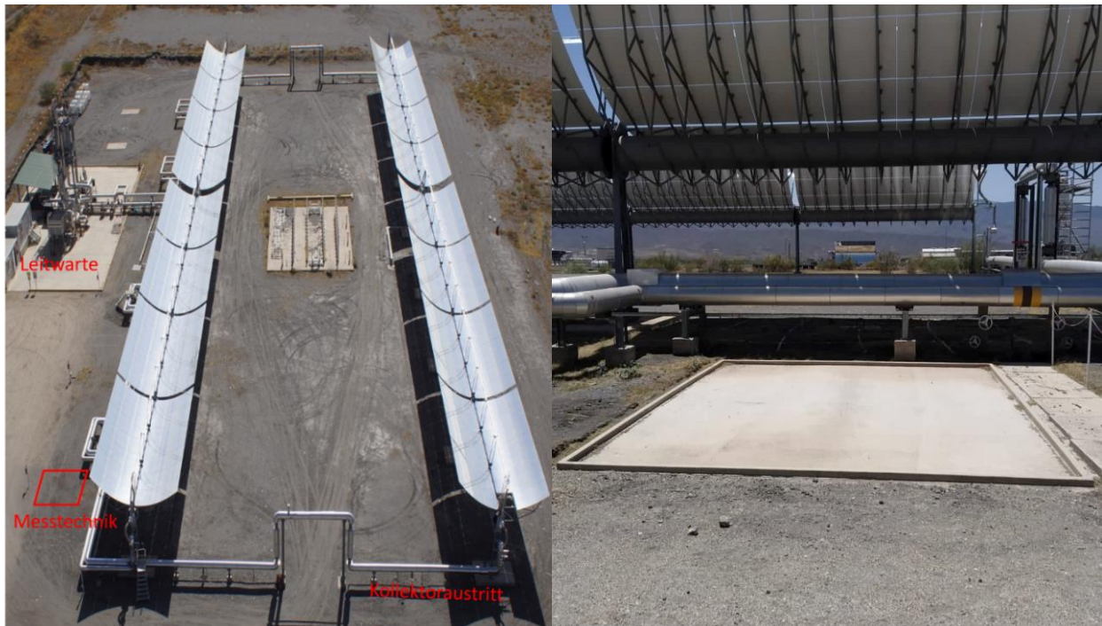
Abbildung 1: links: Lage der neuen Messtechnik an der PROMETEO-Anlage (Luftbild), rechts: fertiges Fundament
