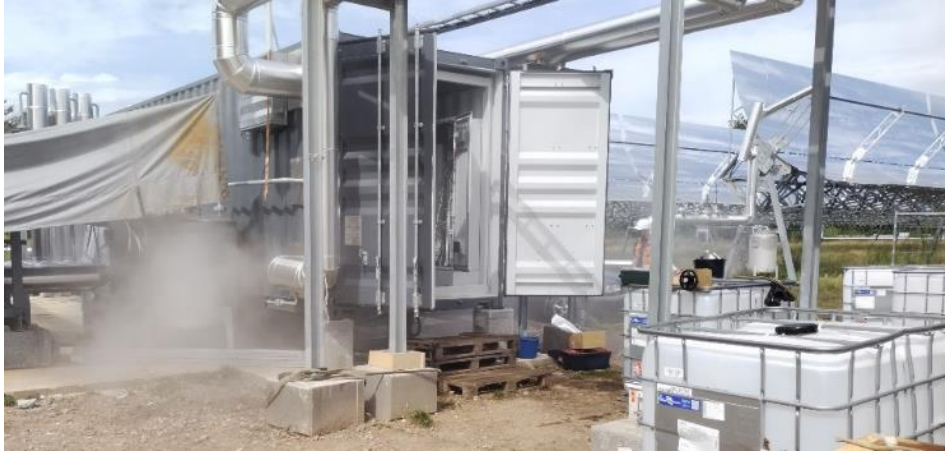
Abbildung 48: Abblasen von Luft, Wasserdampf und Leichtgasen aus dem Helisol
