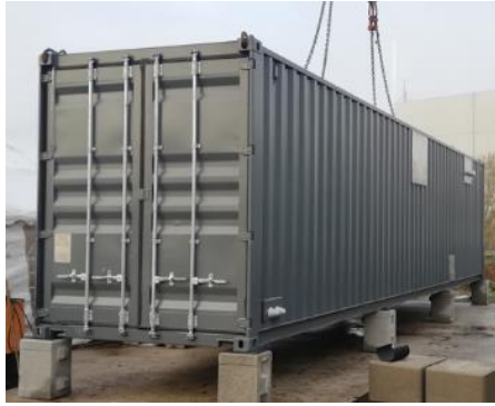
Abbildung 44: BoP-Container wird an Aufstellort verladen
