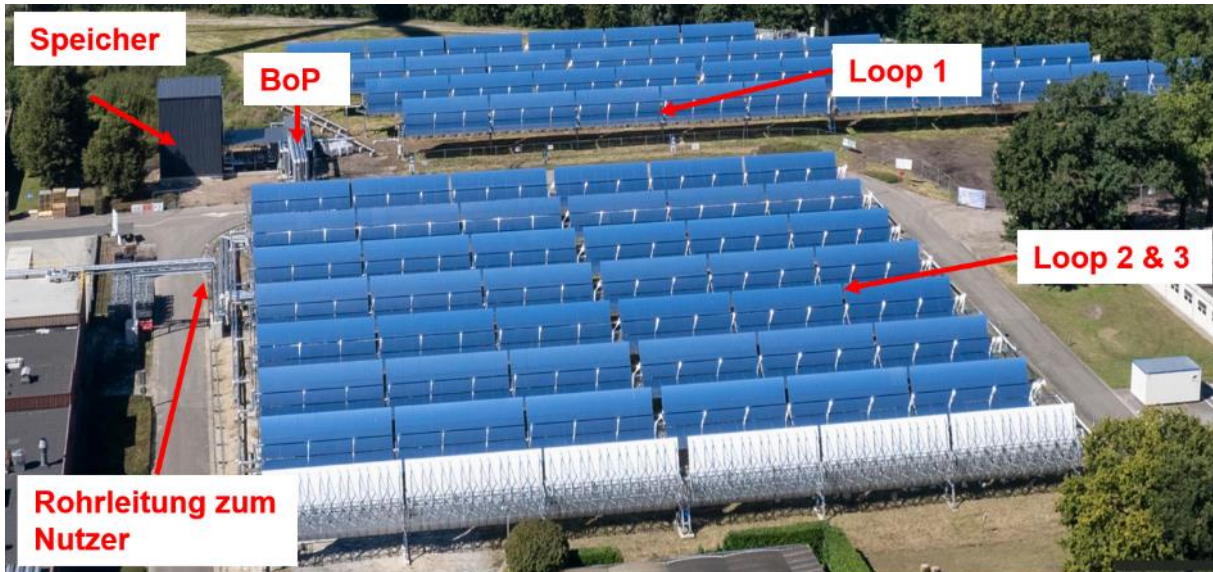
Abbildung 42: Solarfeld, BoP und thermischer Speicher der gebauten Betriebsumgebung 3 (Foto: Avery Dennison)
