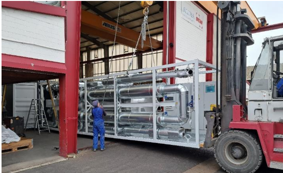
Abbildung 43: BoP wird nach der Montage in den Container geschoben (Foto: AURA)
