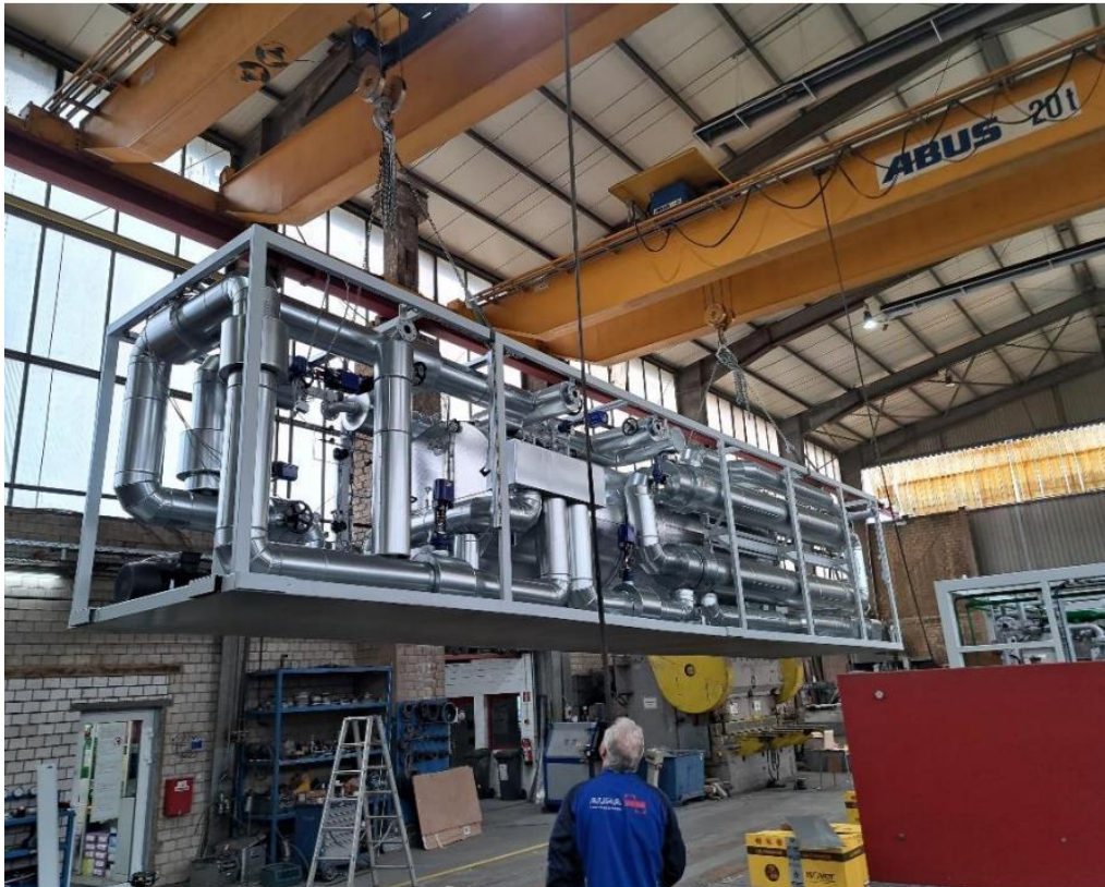
Abbildung 40: Transport des Rahmens und BoP mithilfe eines Krahn
