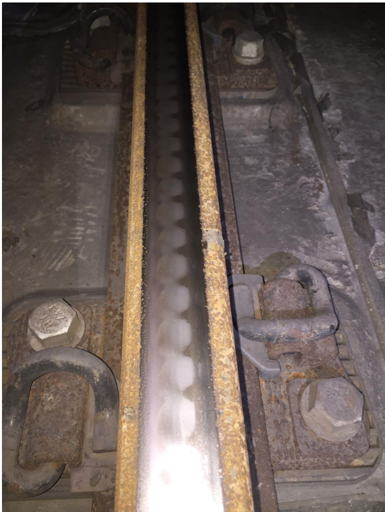
Abbildung 41: Gleisabschnitt mit Riffeln / Schlupfwellen (© Vossloh Rail Services)
