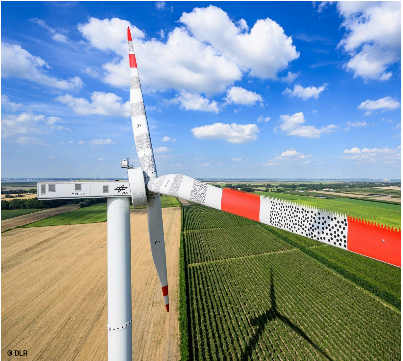
Turbine mit sogenannten Serrations
