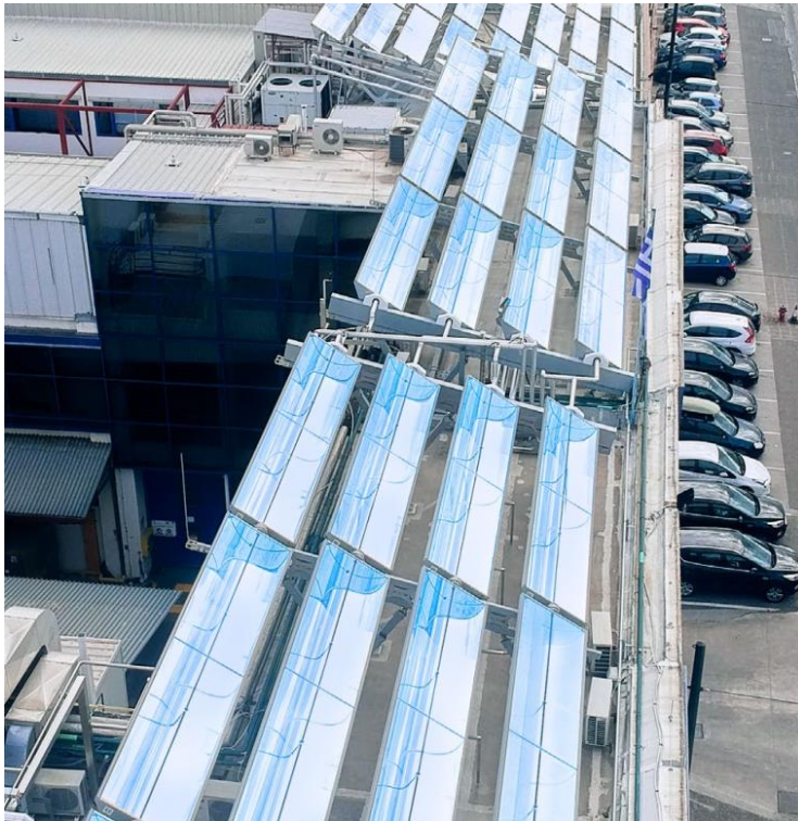
Absolicon T160 Kollektor: 1.1m x 5.5m Quelle: Absolicon
