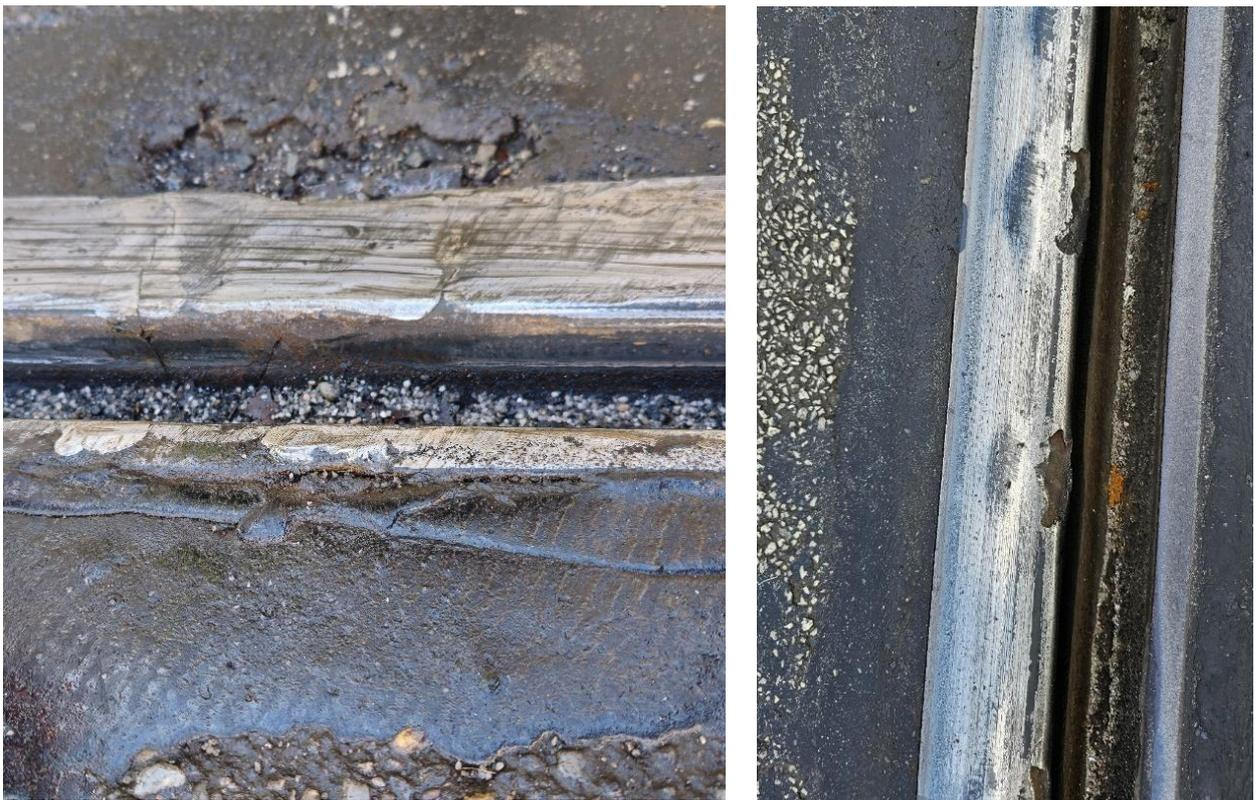
*Abbildung 8. Fotos eines Schienenbruchs (links) sowie eines Schienenkopfausbruchs (rechts) für Beispiele an Gleisschäden, an denen von einer deutlichen Beeinflussung der vibroakustischen Sensordaten ausgegangen werden kann.*
