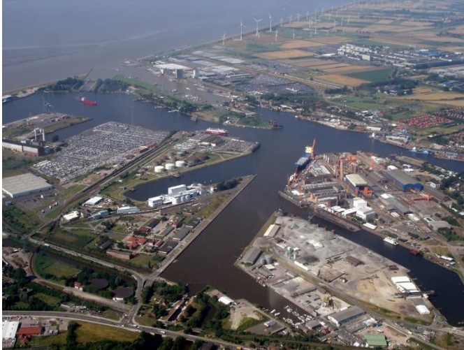
Abbildung 1: Der Emdener Hafen ist Einsatz- und Erprobungsgebiet des hochautomatisierten Baggerschiffs, welches in der Durchführbarkeitsstudie AMISIA konzipiert werden soll. © Adobe Stock – Wolfgang Buchholz
