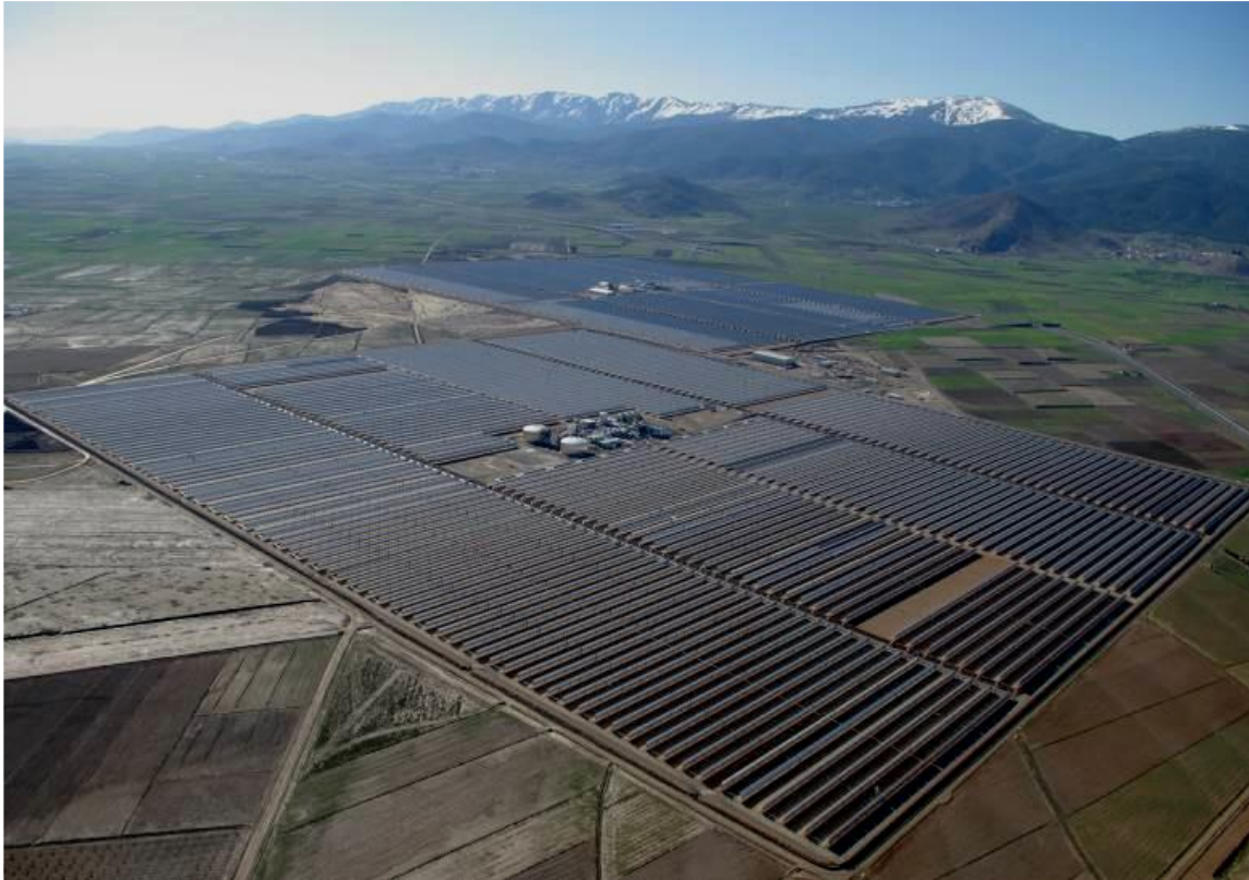
Andasol 1-3 (Spanien): 1.5 Millionen qm Kollektorfläche Elektrische Leistung 3x50 MW Speicherkapazität 8 h
