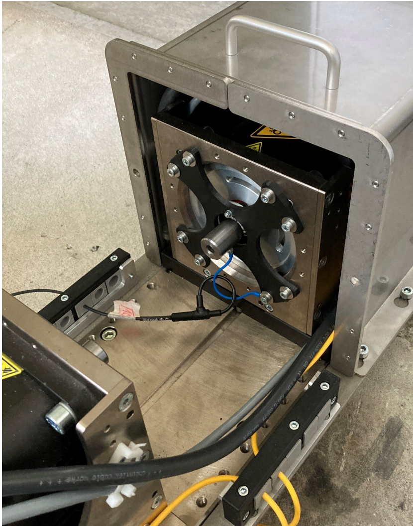
Abbildung 11: Abbildung des eingebauten Wellenerdungsringes (Die Verbindungswelle zwischen den Maschinen wurde zu Demonstrationszwecken ausgebaut.) (Quelle: DLR, Braunschweig)
