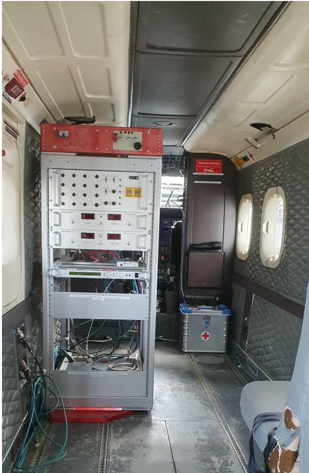
Cockpit Do228 Rack –Einbau
