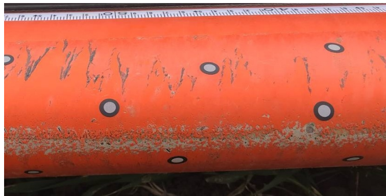
Abbildung 2.7: Erosionsschäden bei 88 % Rotorradius
