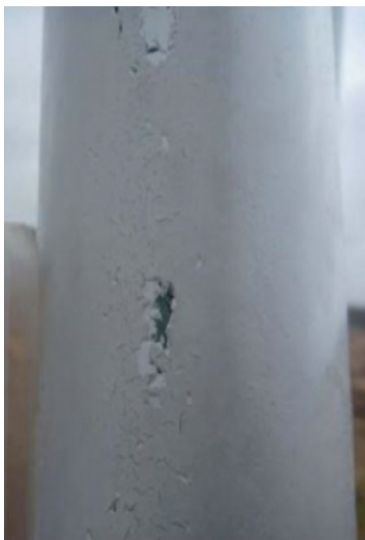
Abbildung 2.3: Lösser in der Oberflächenschicht an der Vorderkante [2]
