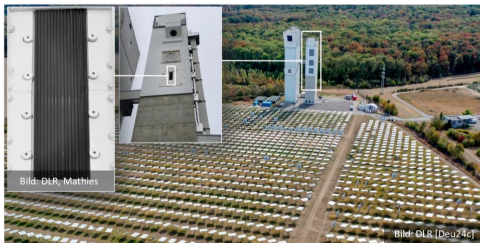
Abbildung 3.2: Multifokusturm Jülich (Bildquelle: [Deu24]) und dort installierter HPMS-II Receiver (Bildquelle: [MAT22])
