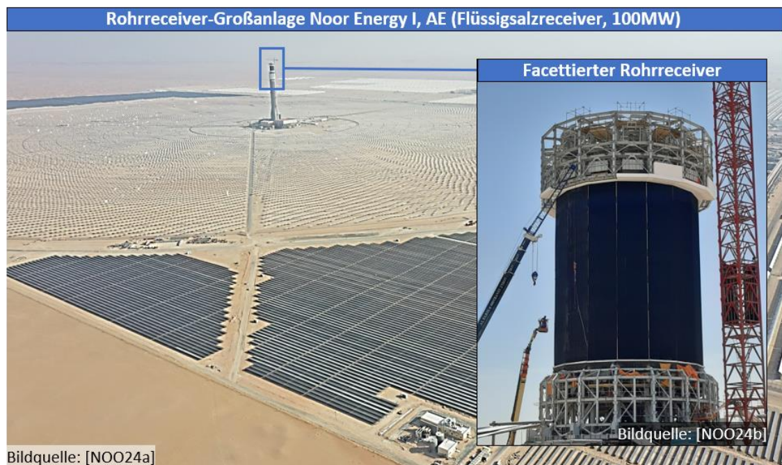
Abbildung 9.1: Großindustrielles Solarturm-Kraftwerk Noor Energy 1 mit facettiertem Receiver-Design
