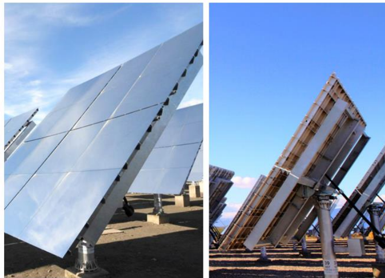
Abbildung 4: Aufbau Heliostaten [5]
