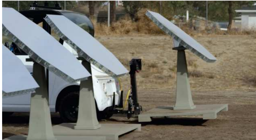
Abbildung 1.10.: Ablegen eines Heliostaten mit Sockelfundament durch ein autonomes Fahrzeug der Firma Heliogen, Inc. [Hel23].
