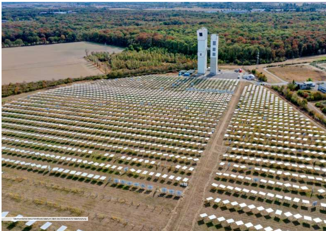
Abbildung 1.14.: Solarturm und Multifokusturm des Instituts für Solarforschung in Jülich, Erstinbetriebnahme 2009 [Ben+21].
