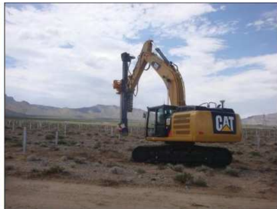
Abbildung 1: Solarturm Jülich des DLR (links), Installation von Heliostat-Pylonen von BSE mittels Ramm-Verfahren (rechts)
