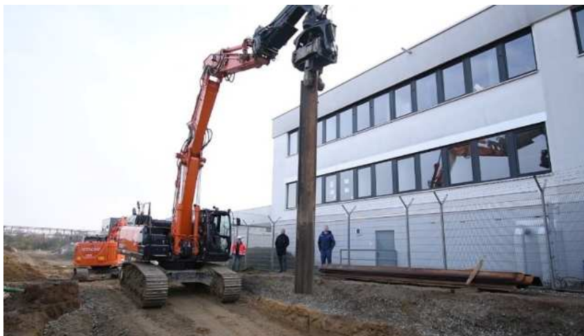
Abbildung 4.15.: Bagger mit freireitender Vibrationsramme der Firma Skancraft [Ska24].
