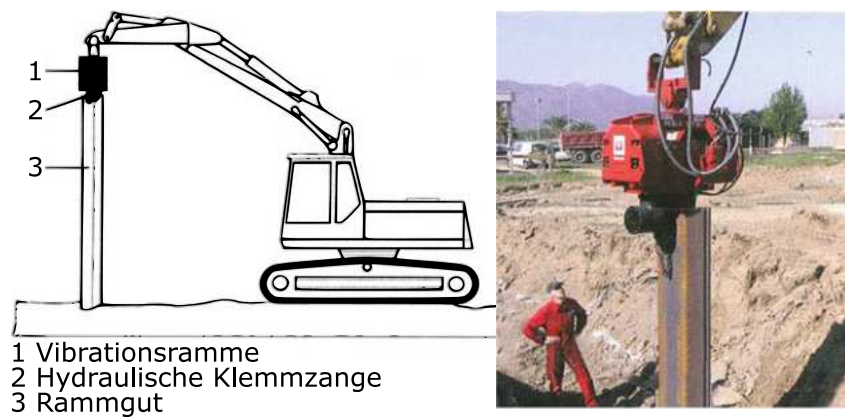
Abbildung 4.1.: Hydraulikbagger mit leichter Vibrationsramme, freireitend [Kön14].
