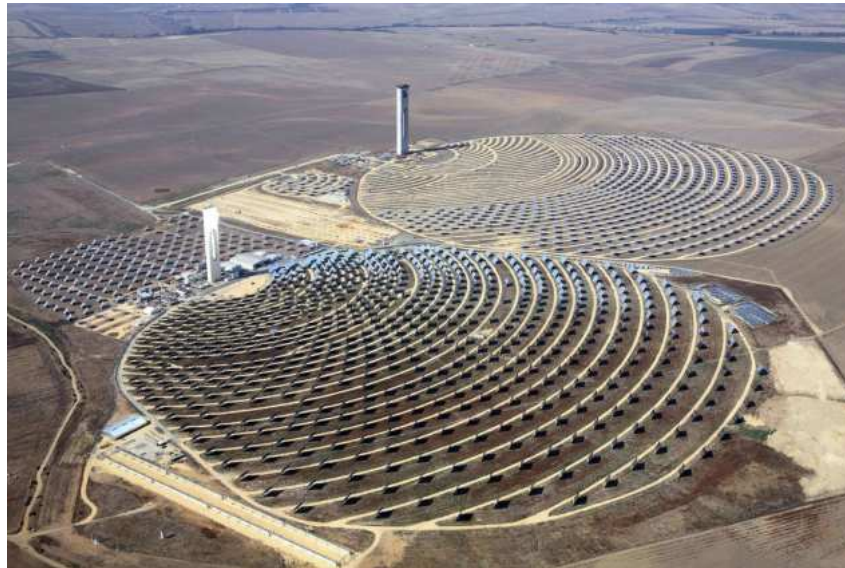
Abbildung 1.4.: Solarturmkraftwerk PS10 (10 MW, vorne) und sich im Bau befindliche Anlage PS20 (20 MW) in der Nähe von Sevilla, Spanien (Aufnahme von 2007) [Koz24].
