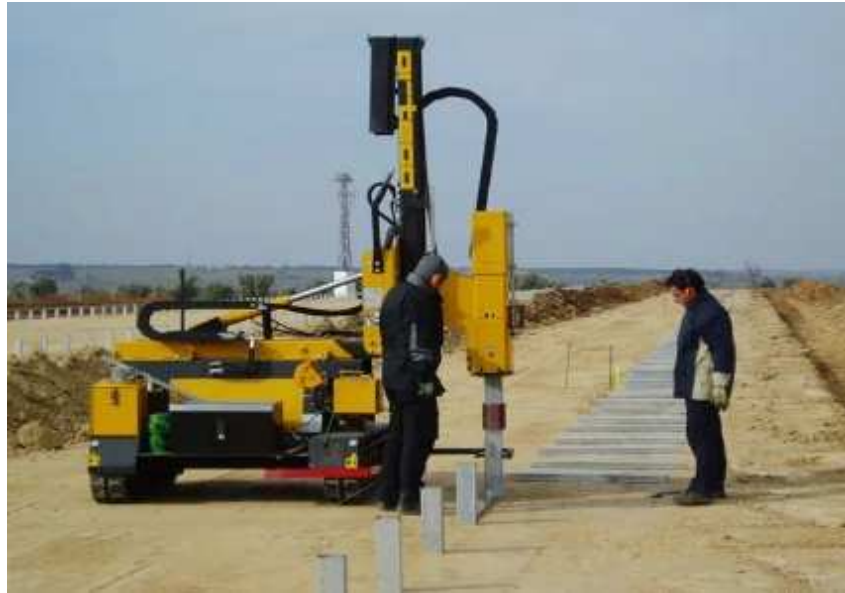
Abbildung 4.16.: Ferngesteuerter Solar Pile Driver der Firma Orteco [Paj23].
