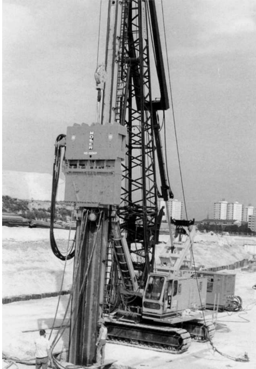
Abbildung 4.3.: Seilbagger mit schwerer Vibrationsramme [Kön14].
