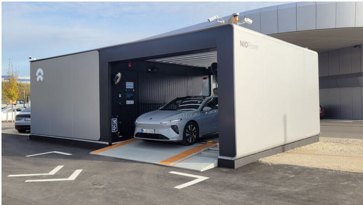
Abbildung 2.1: Batteriewechselstation (Wehner 2022b)
