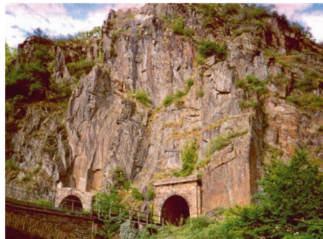
■ Abb. 12.3 Eisenbahntunnel im Ahrtal: Anthropogene Übersteilung einer Felswand durch den Bau von Verkehrsinfrastruktur.
