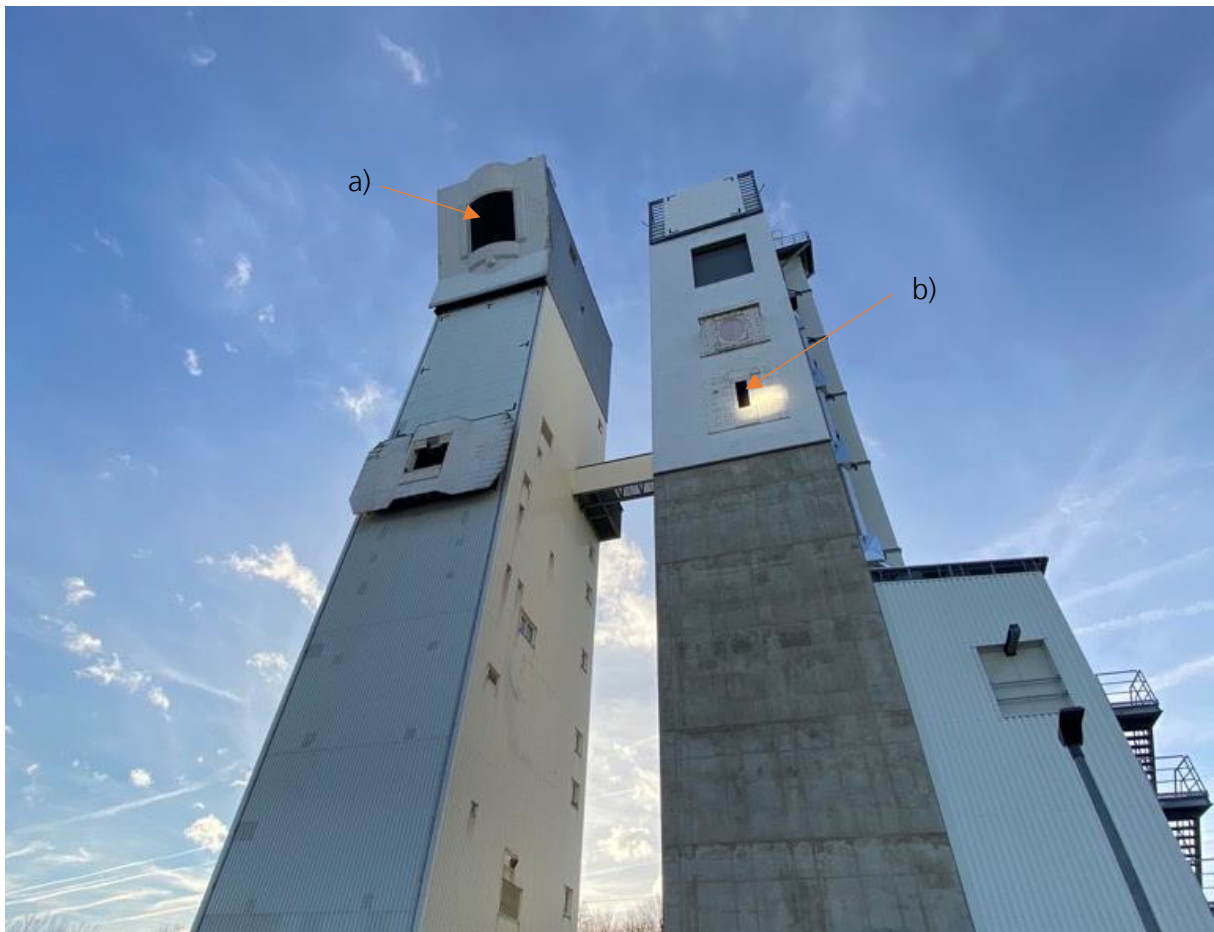
Abbildung 2.6 – Die vom Institut für Solarforschung genutzten Solartürme. a): Hauptsolarturm mit Hauptreceiver b): Multifokusturm inklusive HPMS-II-Receiver
