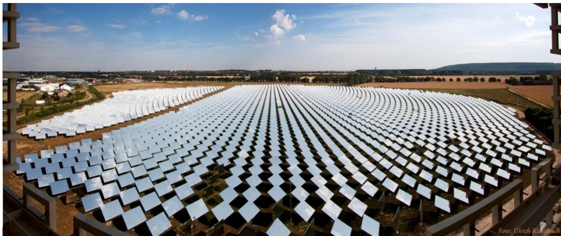
Abbildung 2.5 – Heliostatenfeld des Instituts für Solarforschung des Deutschen Zentrums für Luft- und Raumfahrt (DLR) – Quelle: Ulrich Kieselbach [24]
