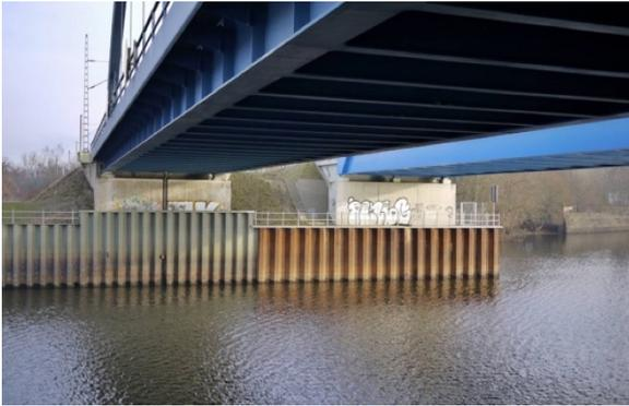
Abbildung 2: Stahlspundwand [vgl. Bars00]
