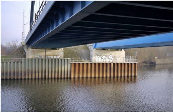
Abbildung 2: Stahlspundwand [vgl. Bars00]
