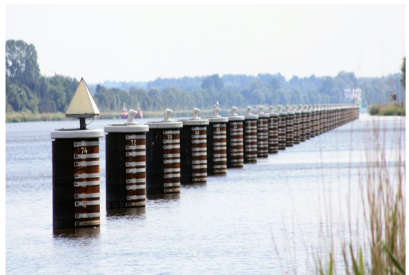
Abbildung 5: Dalben aus Stahl [vgl. Dalb15]
