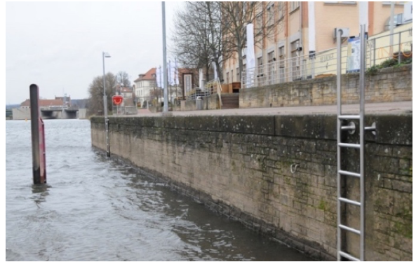
Abbildung 3: Kaimauer aus Stein [vgl. Kaim00]
