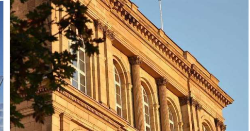
Lehrstühle in Aachen
