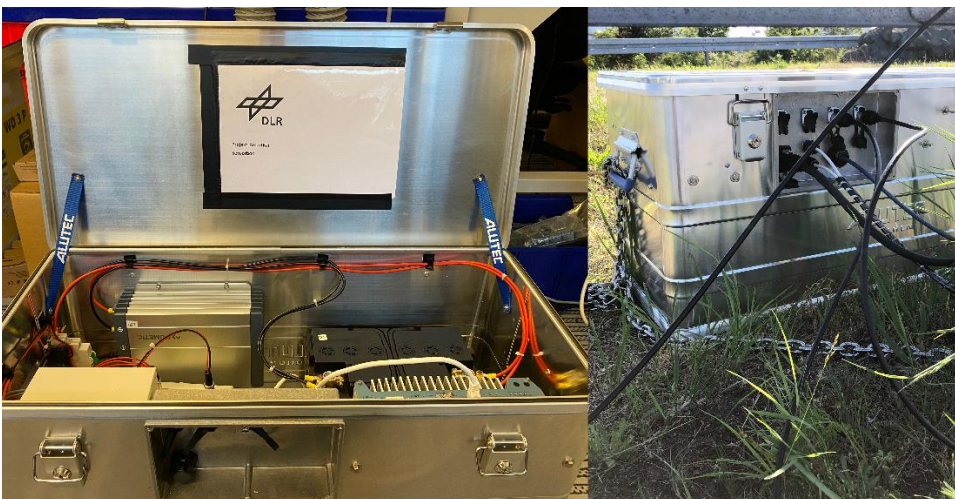
Abb. 3 Sensorverarbeitungsboxen mit IndustriePC, Backup-Batterie und verschiedenen Netzwerkschnittstellen
