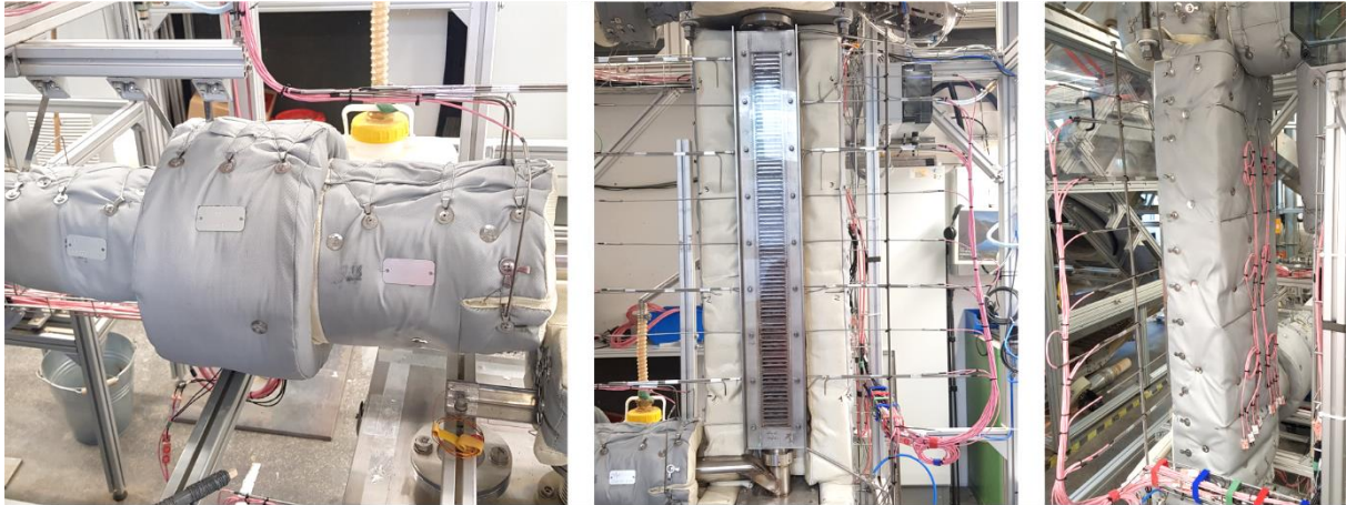
Bild 17: Isolierung des Teststands: Luftzuführung (links), Kanalvorderseite mit abgenommener Isolierung (mitte), Kanalrückseite mit Isolierung (rechts)
