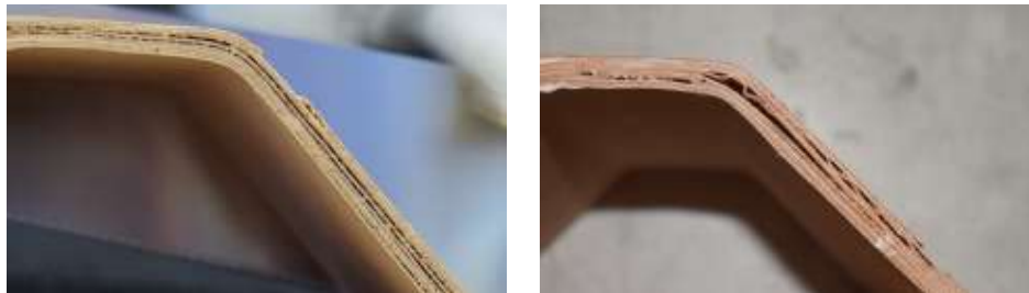
Abbildung 29: Delamination (links) und Falten (rechts) der Furnierlagen im Hutprofil
