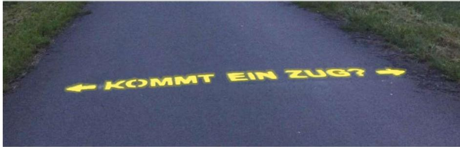
*Abbildung 14* Idee zur Optimierung der Straßenmarkierung zur Erhöhung der Salienz (eigene Modifikation einer Abbildung der ursprünglichen Markierung aus Silla et al., 2019, S. 126).
