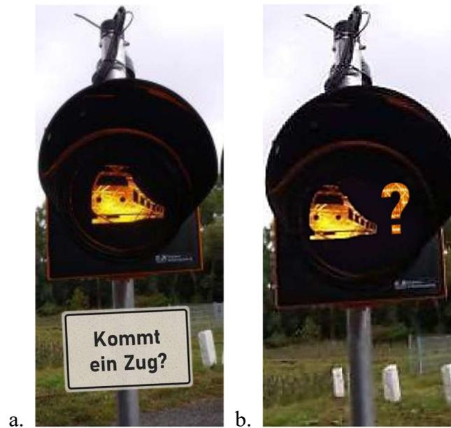
Abbildung 13 Zwei Ideen zur Optimierung des Blinklichts zur Vermeidung von Fehlinterpretationen. a. mit einem Zusatzschild unterhalb des Blinklichts. b. mit einem ergänzenden Fragezeichen hinter dem Zugsymbol (eigene Modifikation einer Abbildung des ursprünglichen Blinklichts aus Silla et al., 2019, S. 127).
