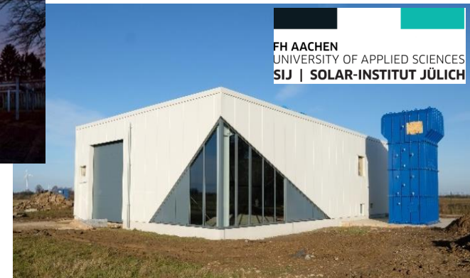
TESS 2.0 (Feststoffspeicher mit P2H)
