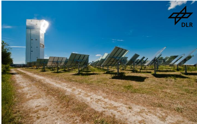
Solarturm Jülich (Keramikspeicher)
