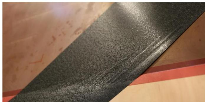
Abbildung 68: Bridging an Rampenkante
