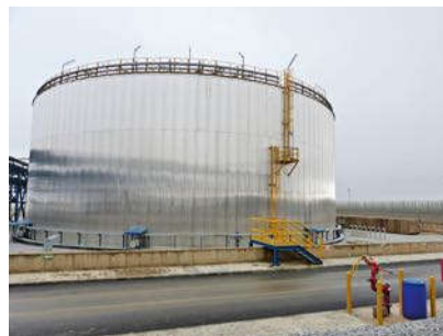
Abb.2-2 Flüssigsalzspeicher in einem solarthermischen Kraftwerk
