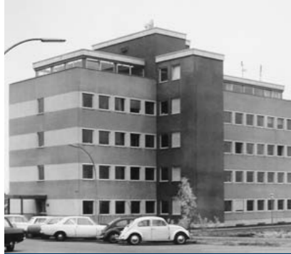
1968: Das neue Gebäude des Instituts für Physik der Atmosphäre in Oberpfaffenhofen mit kleinem Regen-Radar auf dem Dach
