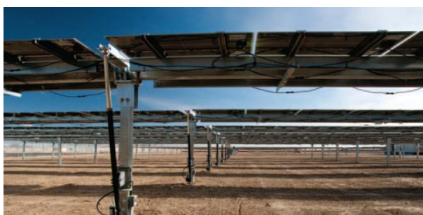
a) 1-achsig nachgeführte PV Anlage (Quelle: First Solar)
