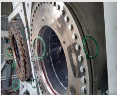
Zwei Einzel-Receiver ohne Sekundärkonzentrator
