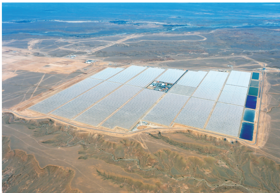
Dampfkraftwerk und Wärmespeicher inmitten des Kollektorfelds der Anlage NOOR 1 in Ouarzazate, Marokko Foto: Moroccan Agency for Solar Energy (MASEN)
