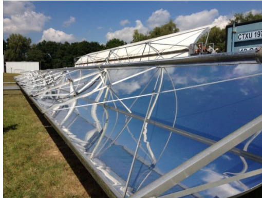
Fig. 2.2 IST collector at SOPRAN facilities
