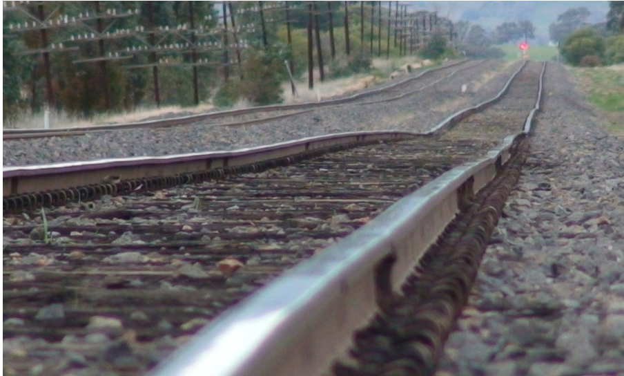
Abbildung 2.7: Gleis mit vertikalen Fehlern [Pic01]
