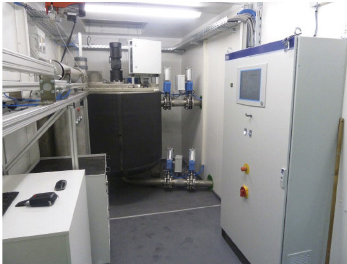
Abbildung 6 Innenraum der portablen Anlage
