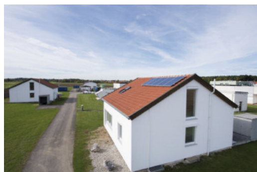
Abbildung 3 Zwillingshäuser Ansicht von Westen.
