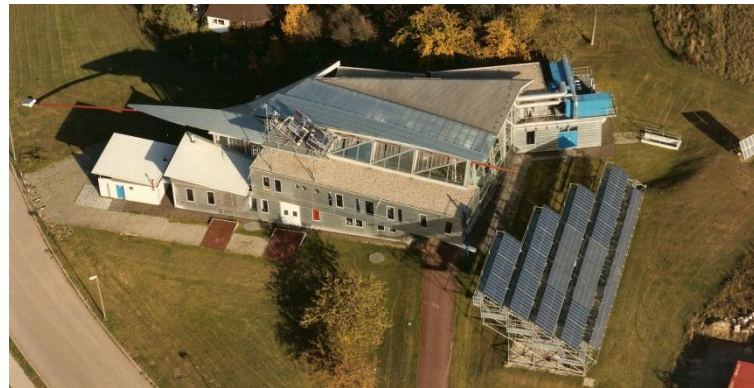
10kW Solar-Wasserstoff Forschungs- und Versuchsanlage
