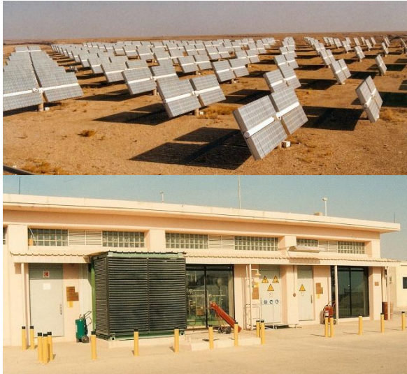
350/500kW Solar-Wasserstoff Herstellungs-Demonstrationsanlage
