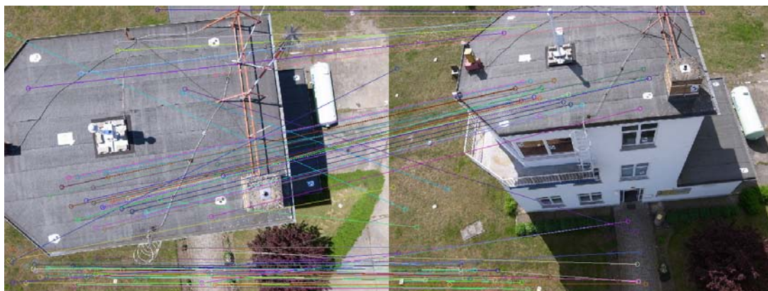
Abb. 4.14: Übergang Dach zu Fassade
