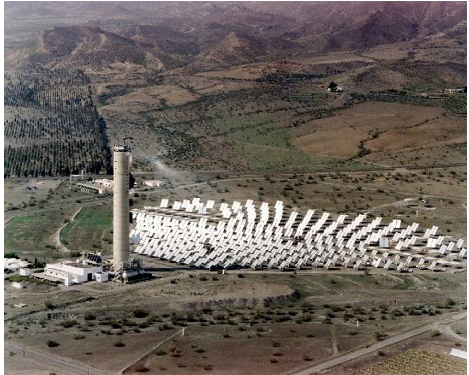
Abbildung 2.2: Turmkraftwerk CESA-1 auf der Plataforma Solar de Almería
