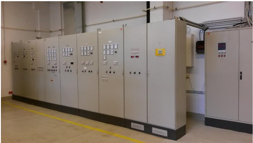
Abbildung 1: Aktuell vorhandene Schaltanlage
