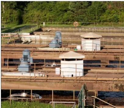
Abbildung 2: Becken mit Belüftungskreisel
