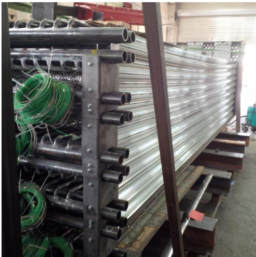
Abbildung 5: Bau des Latentwärmespeichers
