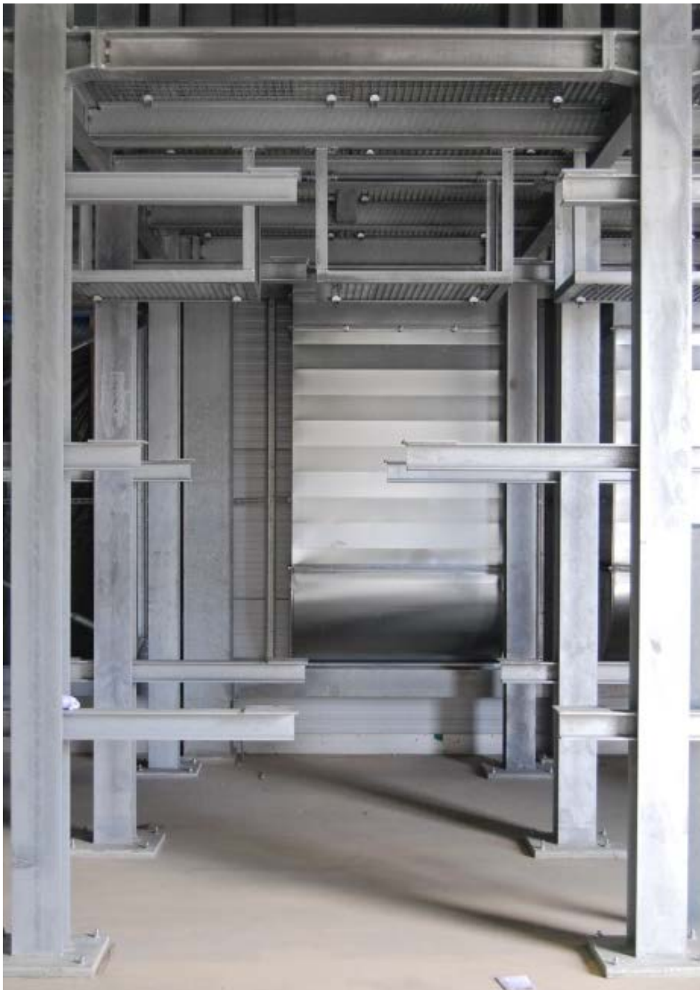
Abbildung 33: Detailaufnahme der Strahlermodulanbringung
